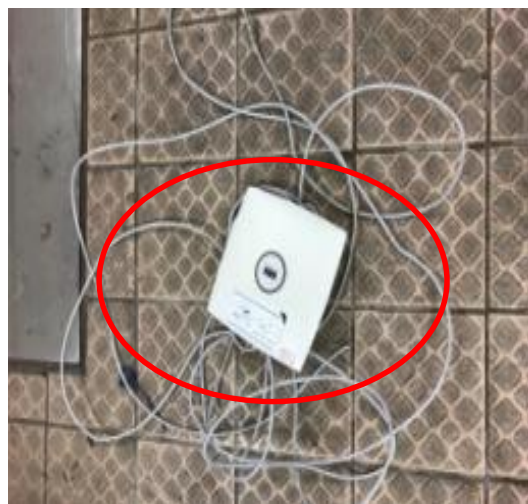
基地台已拆至地上
